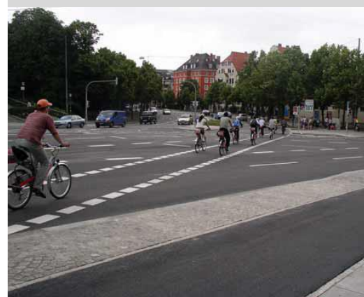
איור 31: דוגמאות לטיפול בנתיבי אופניים במעגל תנועה ומעבר חצייה
